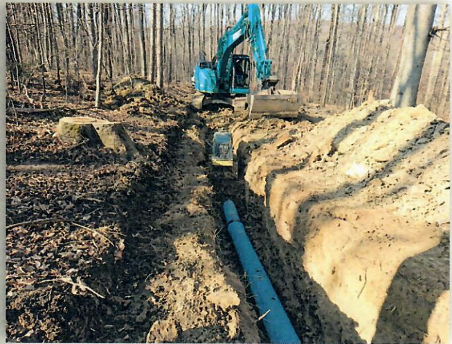
Bau der 2. Wienerwaldleitung DN 300
